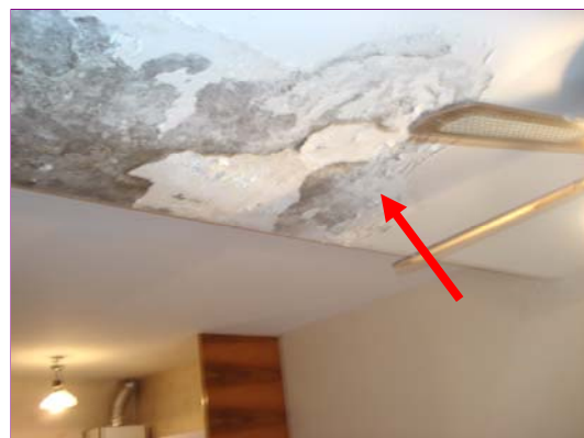
Photo 2 – Appartement rez de jardin - PIEDFER
