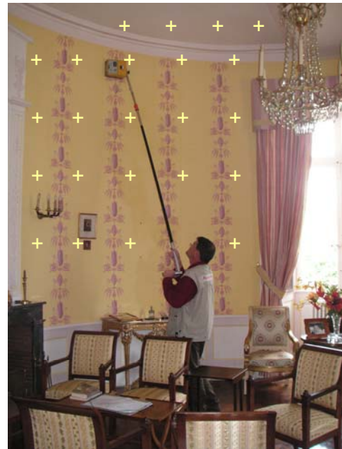
Mur, façade, plafond
